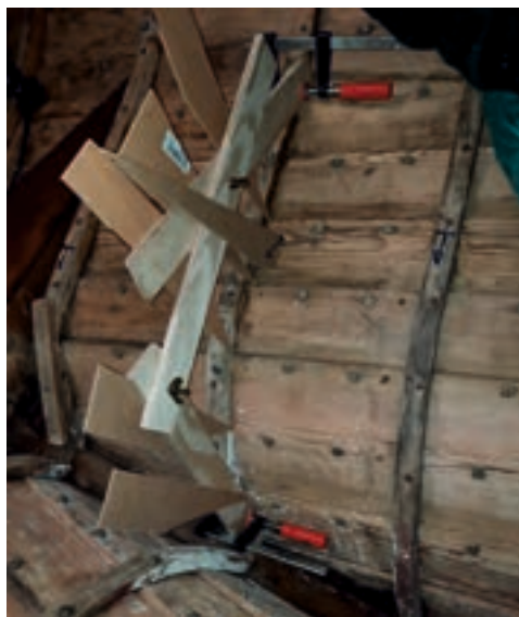
Die Schablone folgt der Spantkontur
