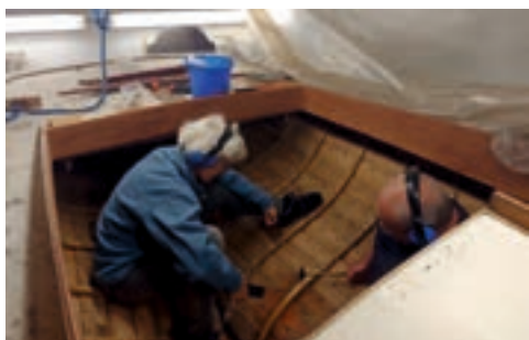
Zu zweit werden die reparierten Spanten mit dem Rumpf vernietet
