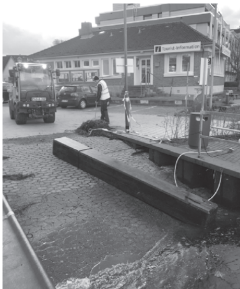
Der Sitzbalken konnte über die Beton-slipanlage wieder aus dem Hafenbecken gezogen werden
