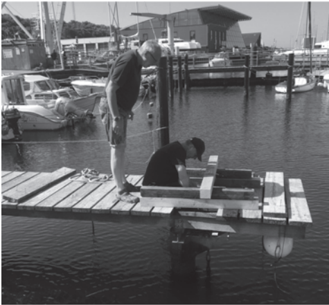
Takelmeister Thomas Möller und Gerätewart Thomas Beyer beim Anheben des beweglichen GFK-Teils an der Jollenslipanlage
